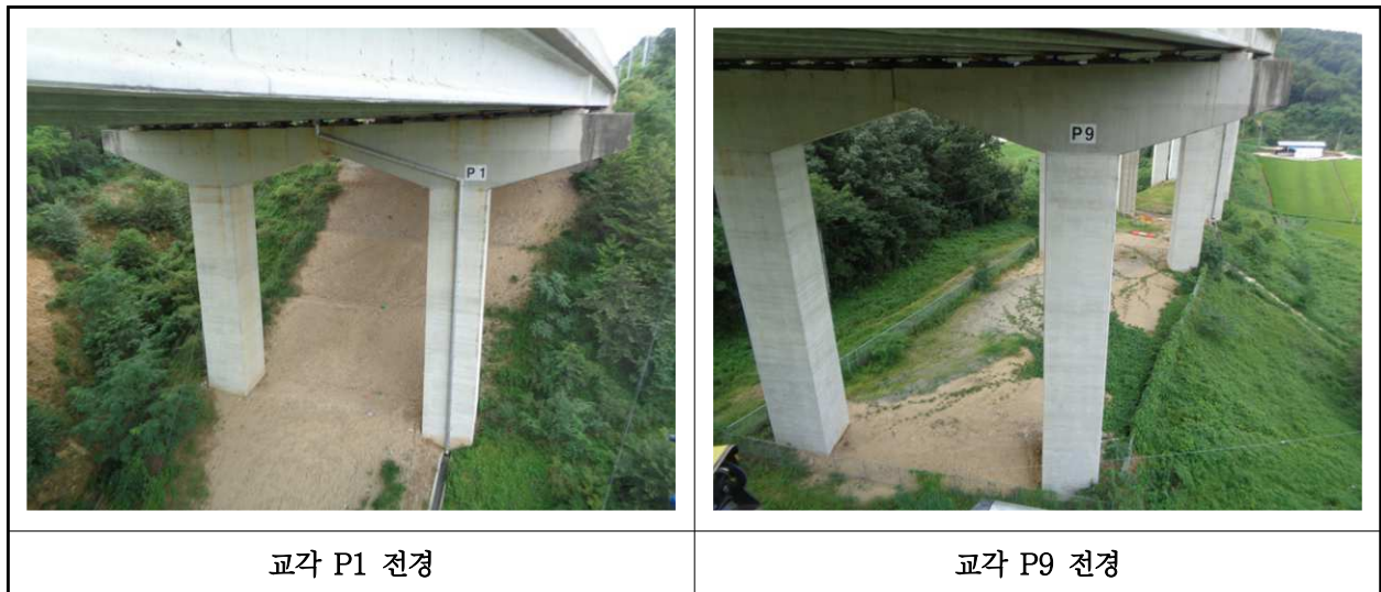
【사진 1.3.10】 교각 전경
