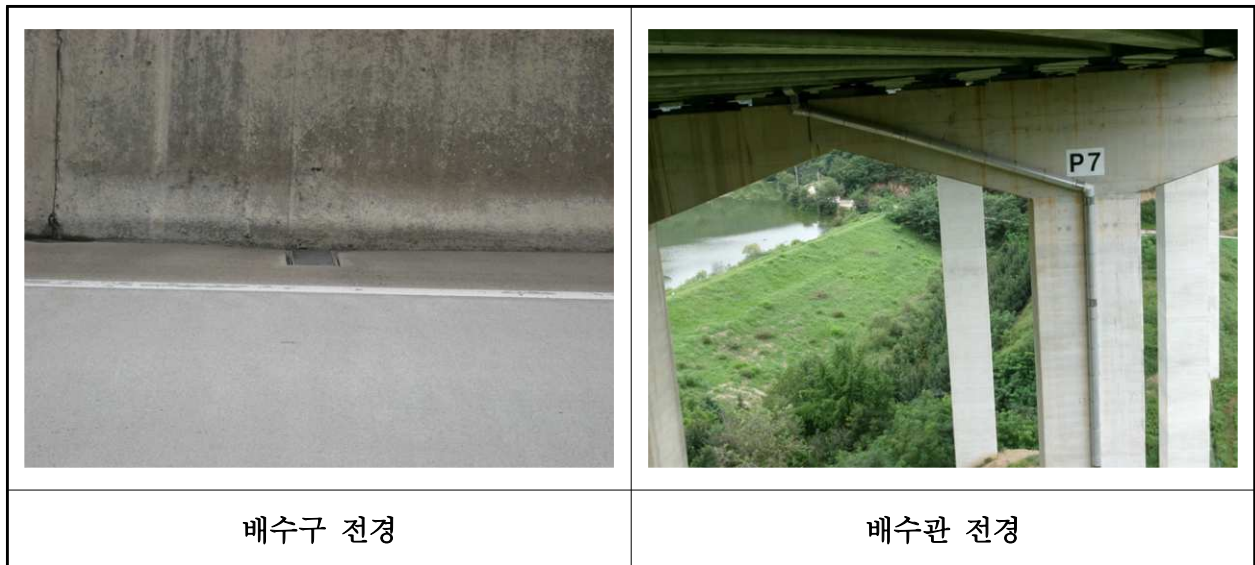
【사진 1.3.21】 배수시설 전경
