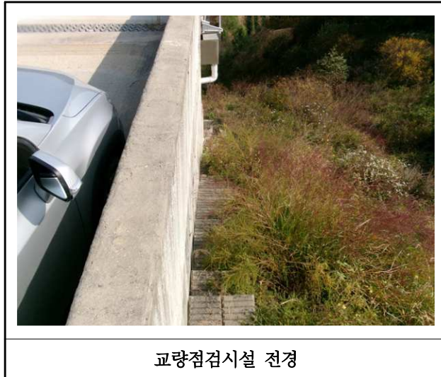
【사진 1.3.50】 교량 점검시설 전경
