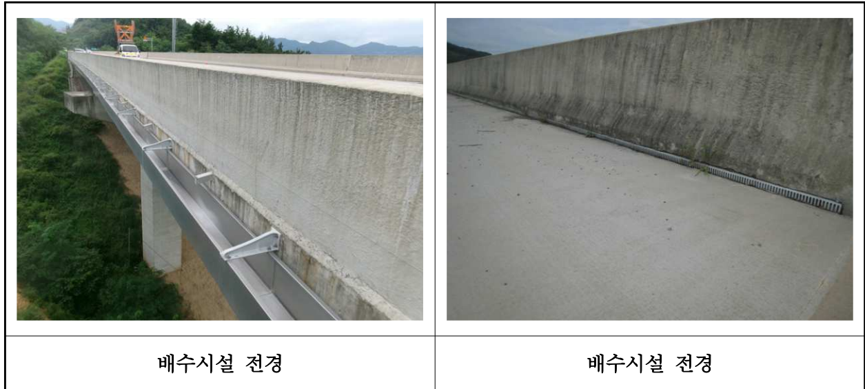
【사진 1.3.46】 배수시설 전경
