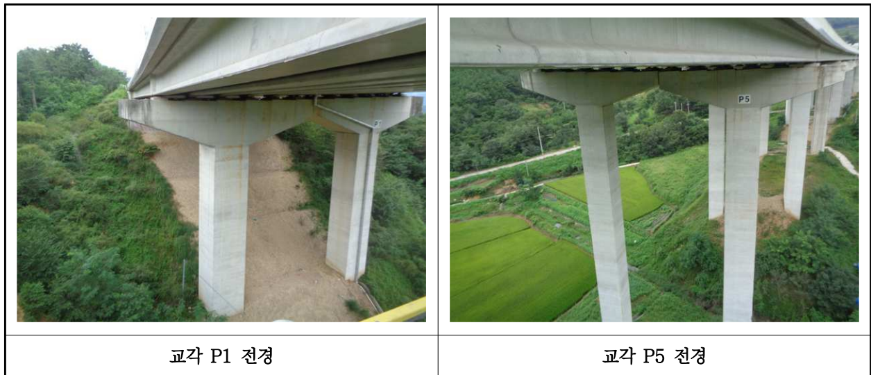
【사진 1.3.35】 교각 전경
