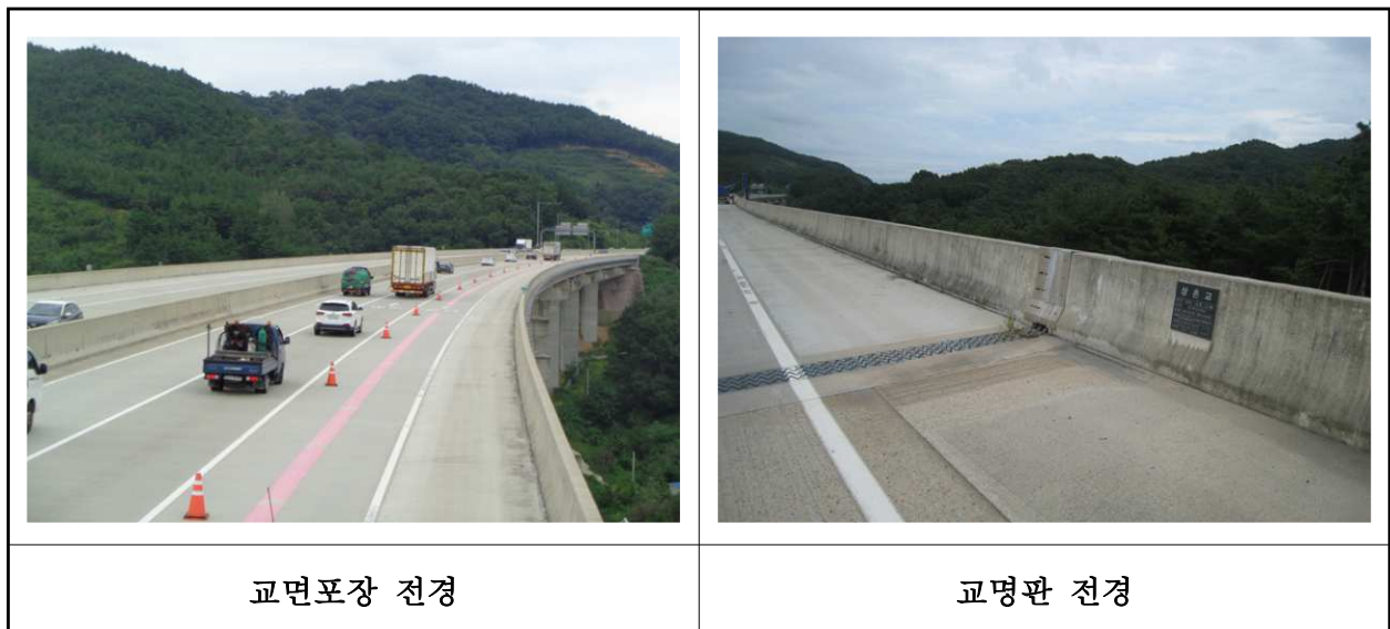
【사진 1.3.44】 교면포장 전경
