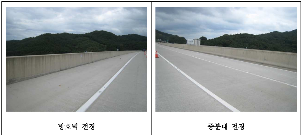
【사진 1.3.23】 방호벽 및 중앙분리대 전경
