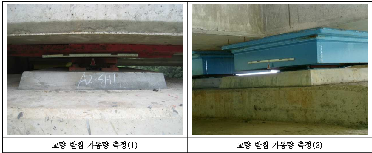
【사진 1.3.15】 교량받침 이동량 측정
