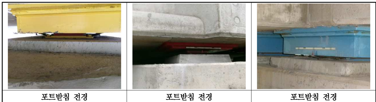
【사진 1.3.12】 교량받침 전경
