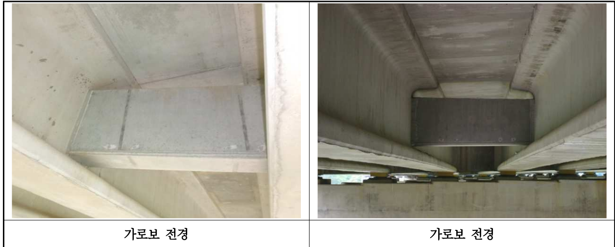
【사진 1.3.31】 가로보 전경
