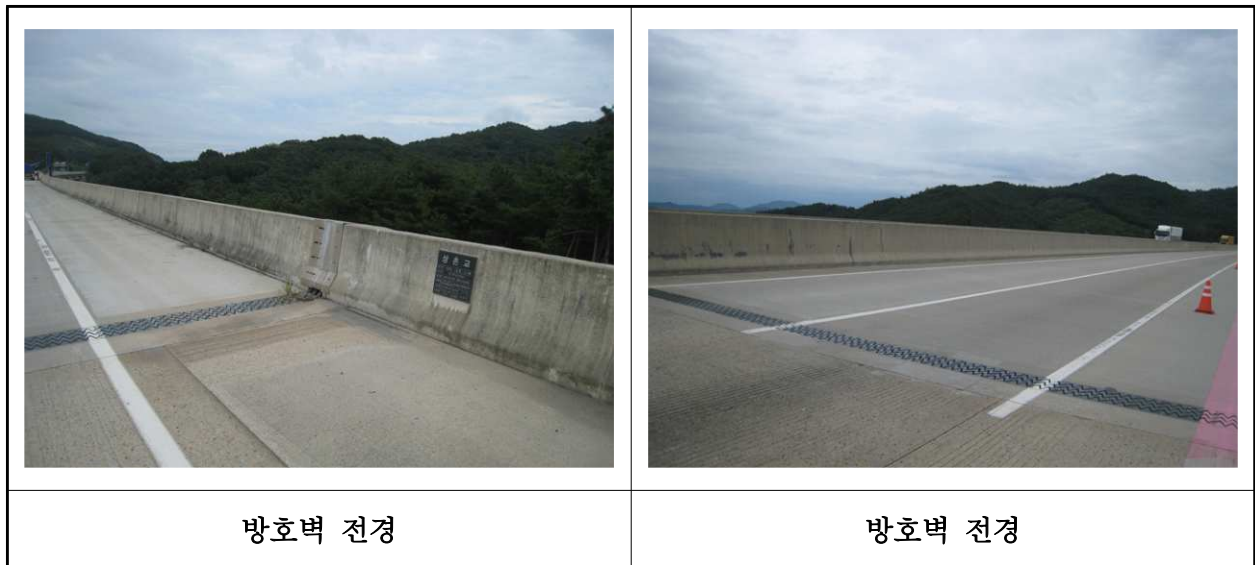
【사진 1.3.48】 방호벽 및 중앙분리대 전경
