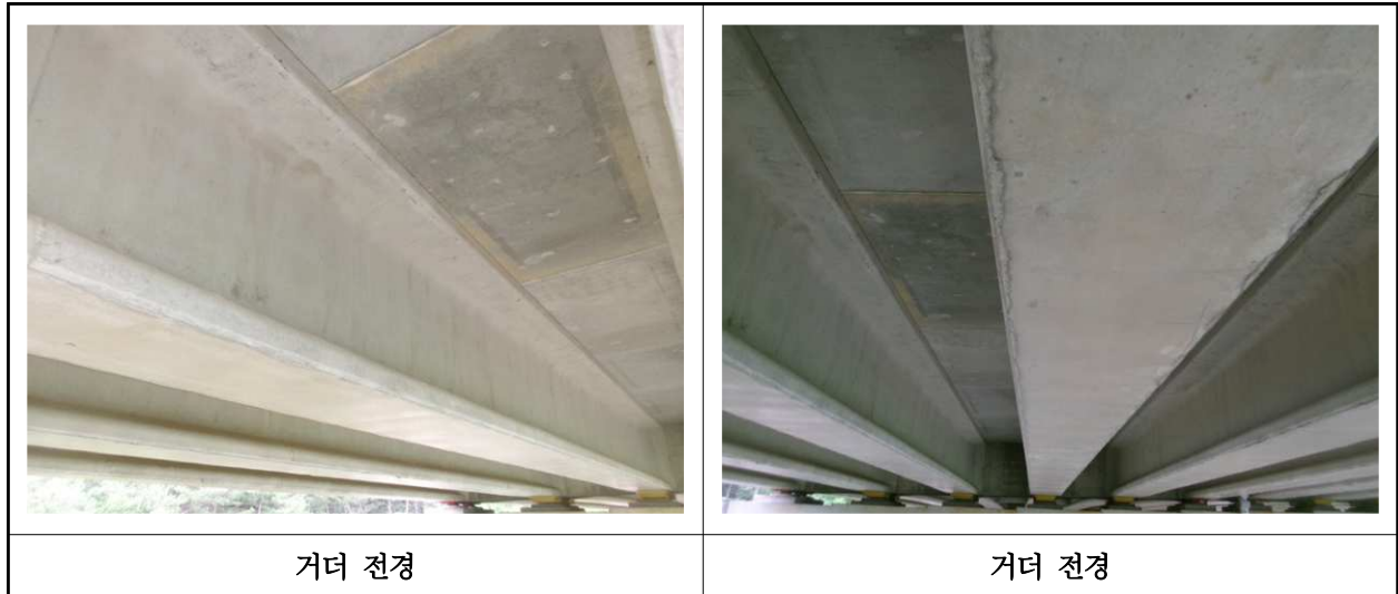
【사진 1.3.29】 거더 전경
